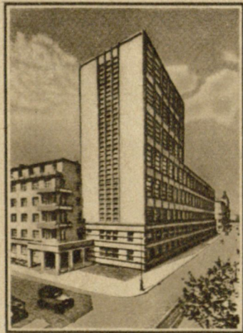
WARSZAWA — URZĄD TELEKOMUNIKACYJNY
